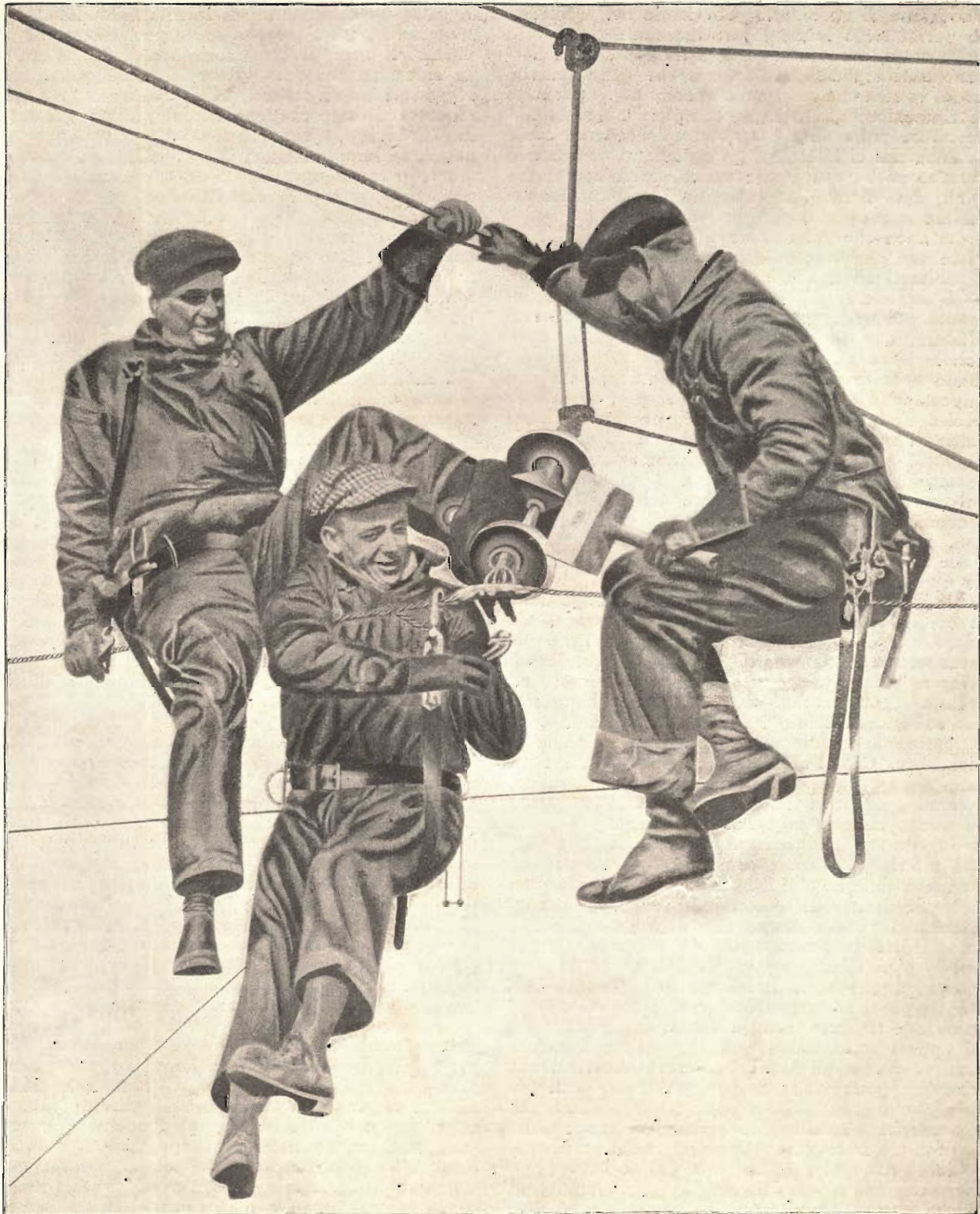
Tra cielo e terra: durante un lavoro di elettrificazione ferroviaria.
